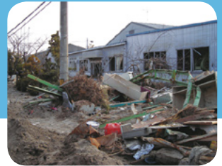
宮城県岩沼市の沿岸部工業団地 (11年4月2日撮影)
